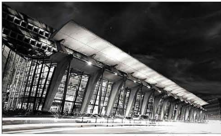
FOTOGRAFIA STANICE V LUZERNE - POHLAD NA NOSNÚ EXTERIÉROVÚ KONŠTRUKCIU ZDROJ: INT. STRÁNKA, CIT. 10.11. 2019 - https://www.flickr.com/photos/markvanraai/5182737938/
