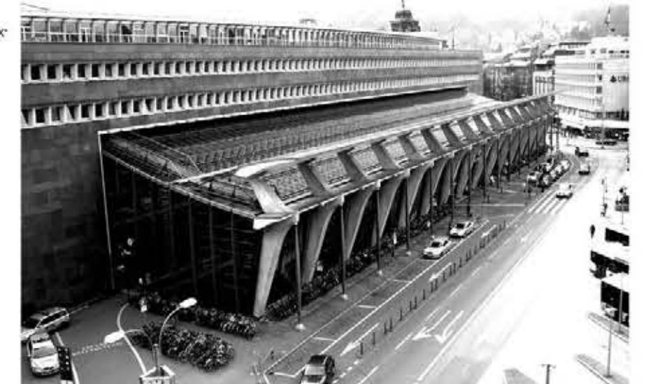
POHLAD ZHORA NA CELÚ STREŠNÚ KONŠTRUKCIU - PREKRYTIE VSTUPNEJ ČASŤI ZDROJ: INT. STRÁNKA, CIT. DŔA: 16.11.2019, https://www.flickr.com/photos/featzee43/4524290816/
