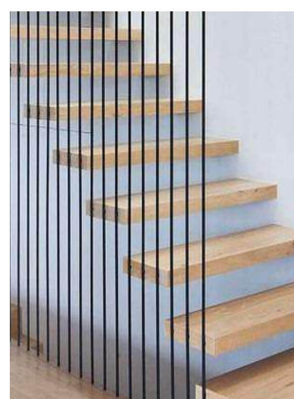
_PRÍKLAD SKRYTÉHO KOTVENIA
