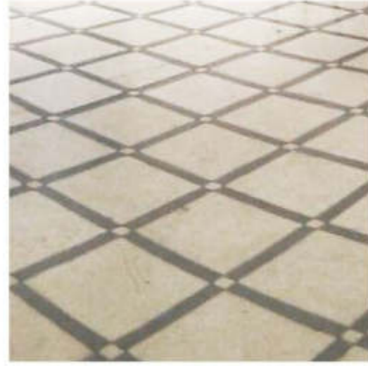
Pôvodná kamenná podlaha
