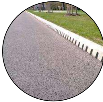
Asfaltová komunikácia s obrubníkom pre odvádzanie zrážkovej vody
