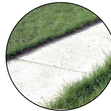
Chodníky z recyklovaného betónového odpadu
