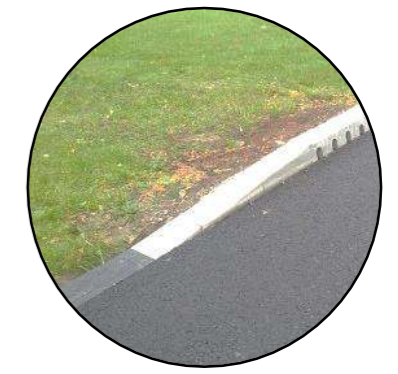
Asfaltová komunikácia s obrubníkom pre odvádzanie zrážkovej vody
