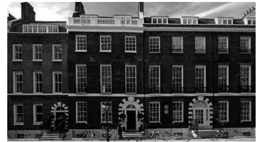
15 Ilustračné foto prostredia AA (Architectural Association) – desať radových viktoriánskych domov tvorí školu architektúry
