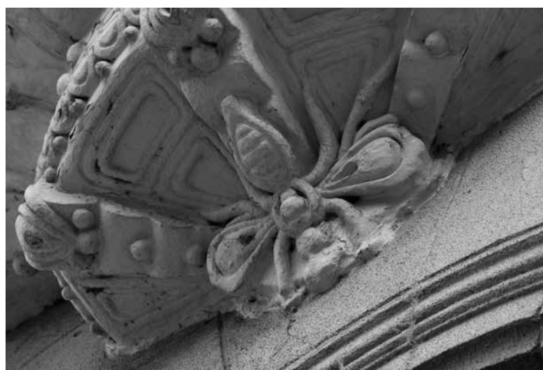
18 Detail fasády s motívom včely, bývalá budova sporiteľne pre Komárno a okolie v Komárne
