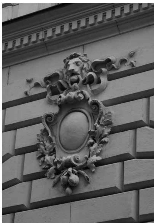
5 Detail fasády s motívom levej hlavy, bývalá pobočka Rakúsko-uhorskej banky v Nitre
