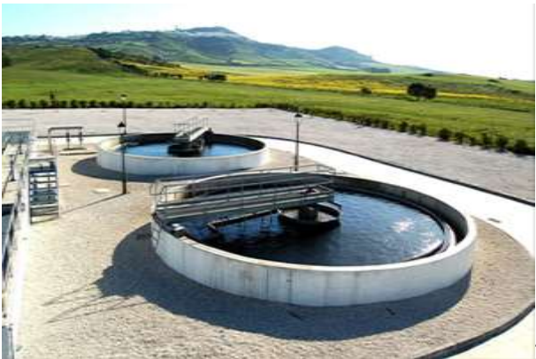
Čistiareň odpadových vôd
