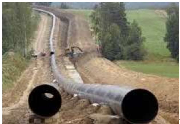
Výstavba plynovodu, podzemná hĺbená stavba
