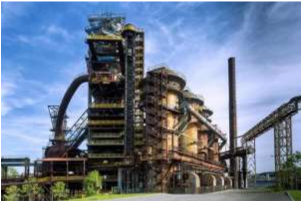
Vysoká pec, Ostrava
