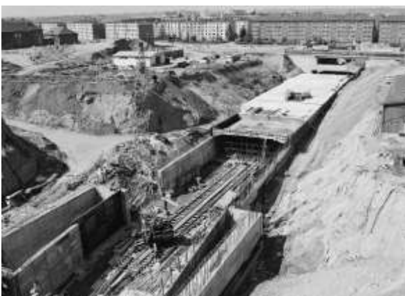
Metro Praha- výstavba kombinovanými metódami – hĺbené a razené úseky
